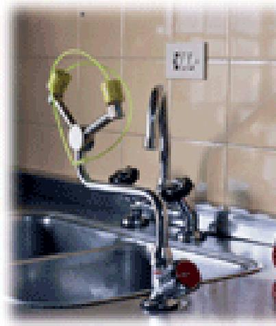
ESTE LAVAOJOS FABRICADO TOTALMENTE EN BRONCE CROMADO, ESTA ESPECIALMENTE DISEÑADO PARA SER USADO EN MESADAS DE LABORATORIOS, PERMITIENDO UTILIZAR LA MISMA INSTALACION DE LA PILETA DE TRABAJO.
